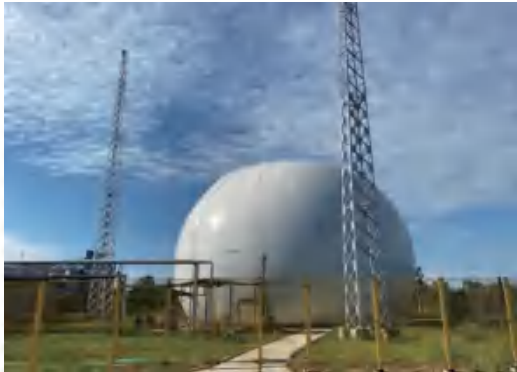
水井坊邛崃基地沼气发电项目
